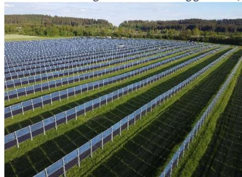
Abbildung 9: vertikal montierte, nach Ost-West ausgerichtete PV-Reihen bei Donauschlingen (Foto: Next2Sun GmbH)
