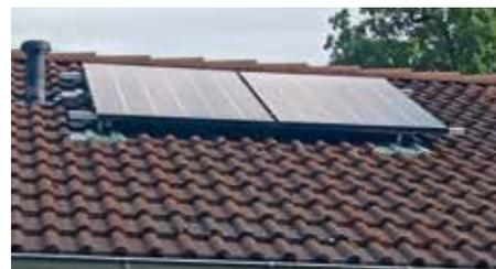
**Balkonkraftwerken bzw. Mini-PV** hinzugekommen. Die Anlagen mit einer Leistung von bis zu 0,8 kWp können einfach und ohne Umbaumaßnahmen montiert werden
